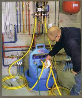
La performance et la longévité d'une installation de chauffage central dépendent de la qualité de l'eau circulant dans le réseau de radiateurs ou le plancher chauffant. Avant le remplacement du générateur (chaudière ou pompe à chaleur) mais aussi des radiateurs, un nettoyage peut s'avérer nécessaire pour éliminer les boues et le tartre.
